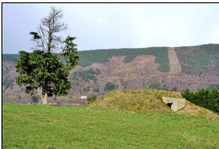
Imagen 12 : Una de las edificaciones a las que nos hemos referido como "búnker" en este informe.
